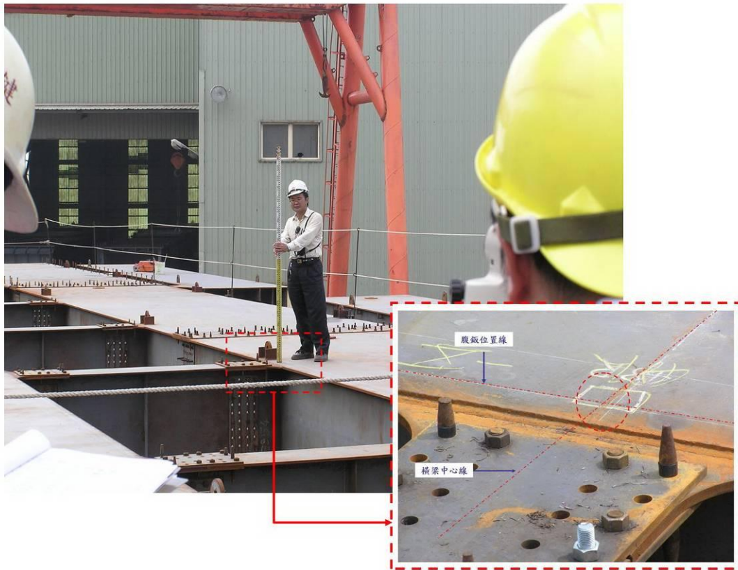
照片 40 主梁與橫梁銜接處高程檢測位置
