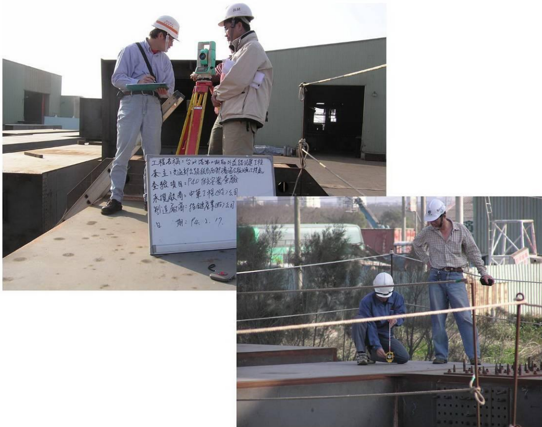
照片 34 預裝構件以光波測距儀量測
