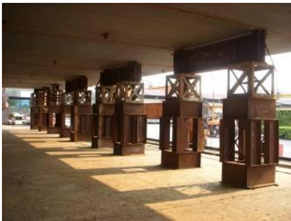
照片 26 構件採多點支撐(春源鋼構)
