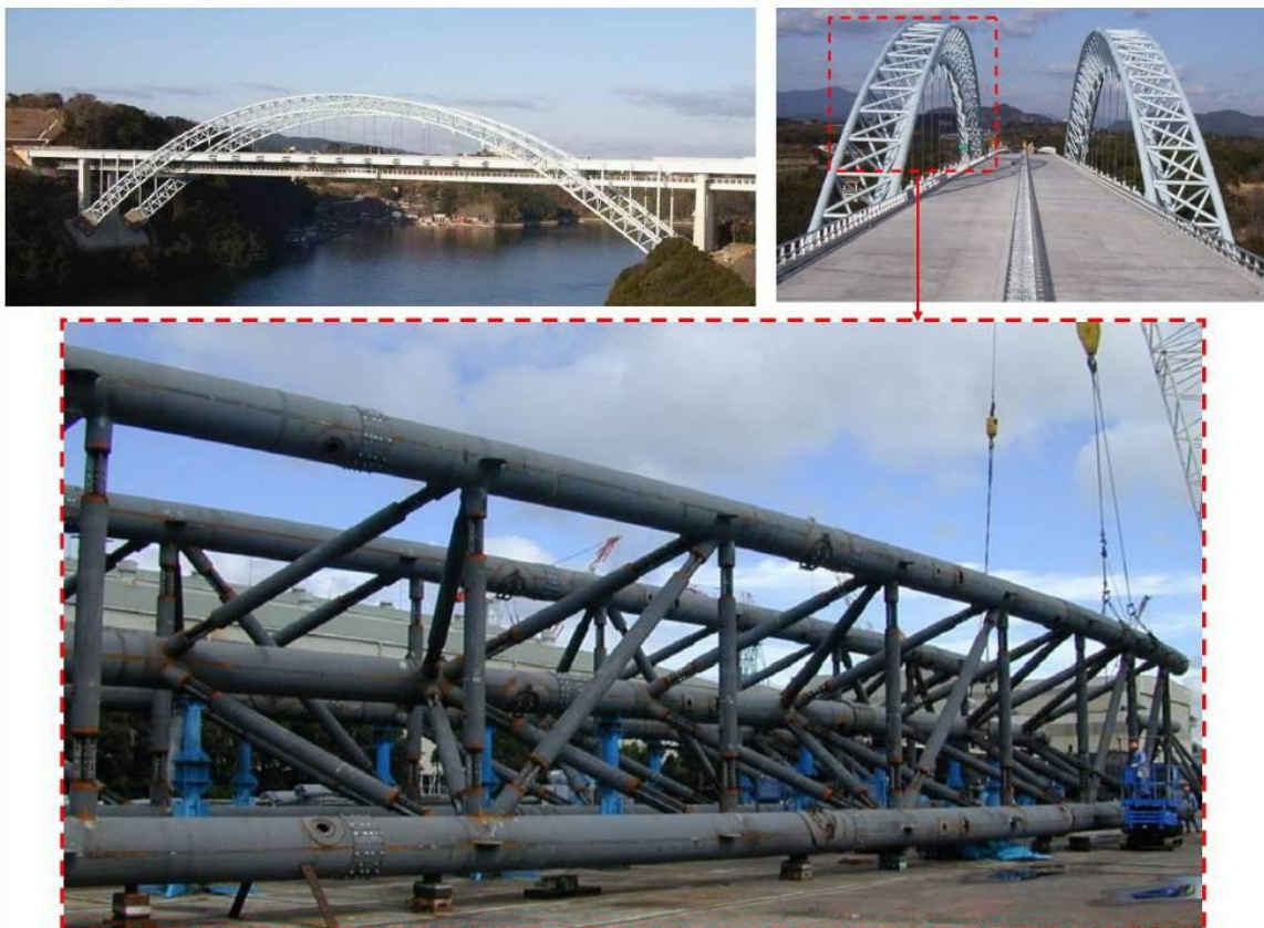
照片 8 橫向預裝(鋼管桁架橋)
