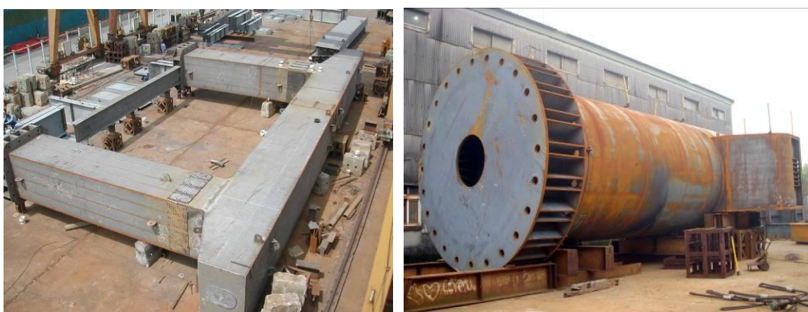
照片 9 橫向預裝(鋼墩柱)
