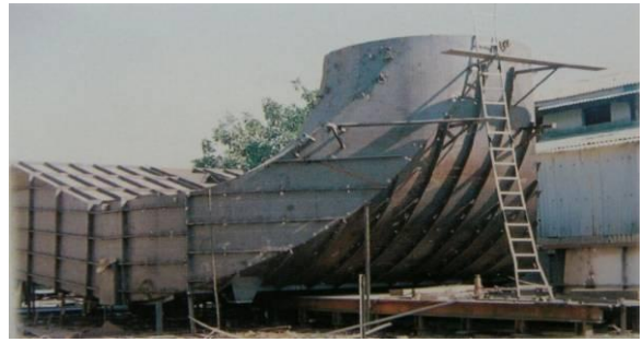
照片-4 水力發電設備 (大將作鋼構)
