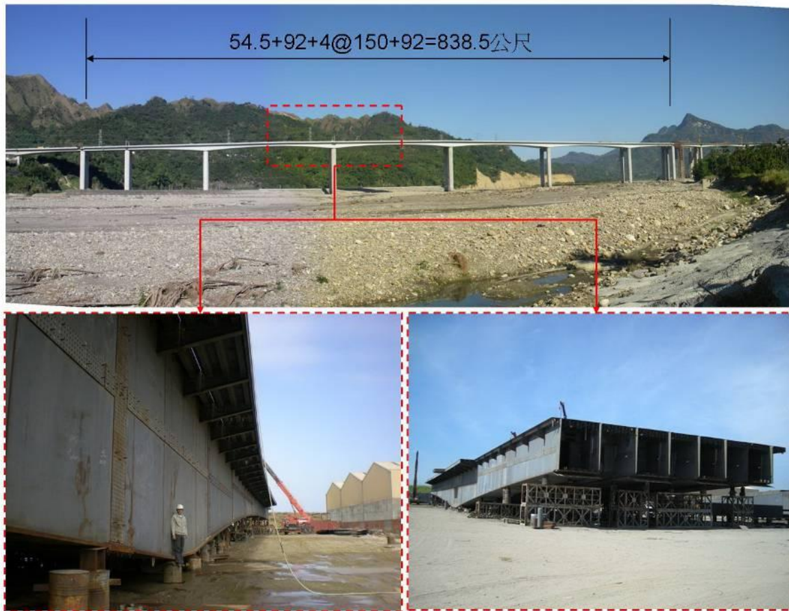
照片 14 分段組合(國道 6 號 C606A 標國姓高架橋-大將作鋼構)
