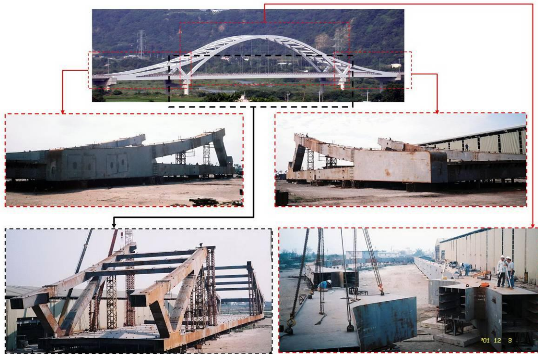
照片 17 台 4 線坎津大橋分段組合示意圖
