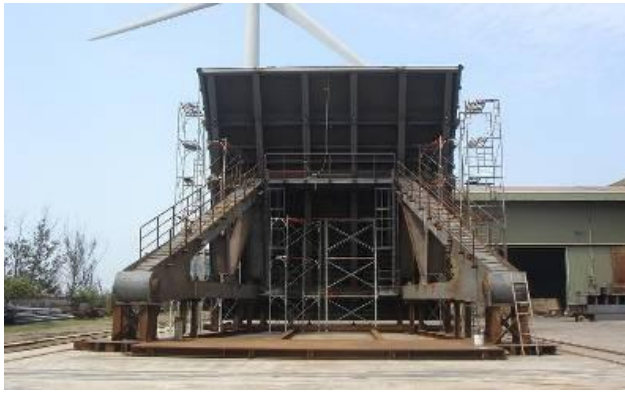
照片-3 溢洪道閘門 (大將作鋼構)
