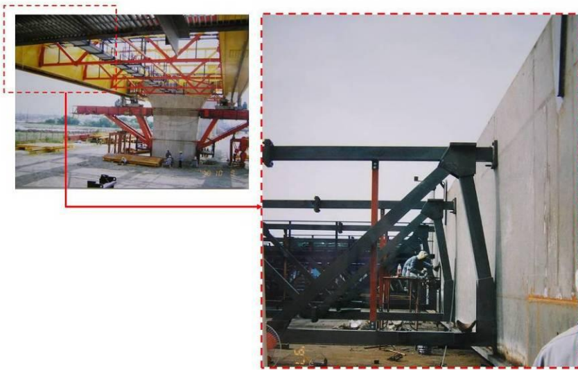
照片 22-1 支撐先進工作車支撐城桁架與主梁接合處
