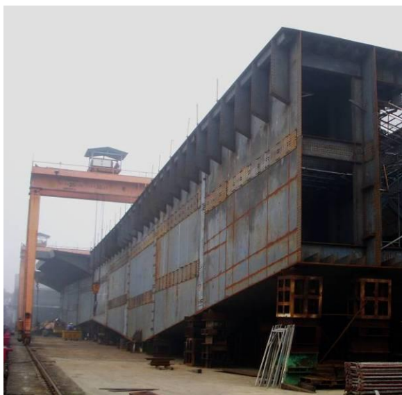
照片 15 分段組合(國道 1 號五楊段高架橋-春源鋼構)
