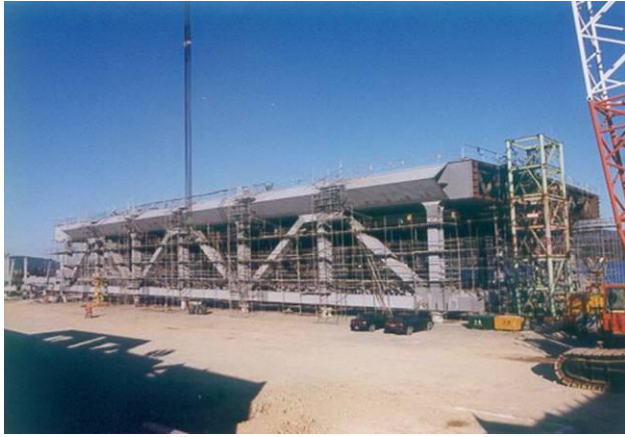
照片 20 吊橋之加勁桁架
