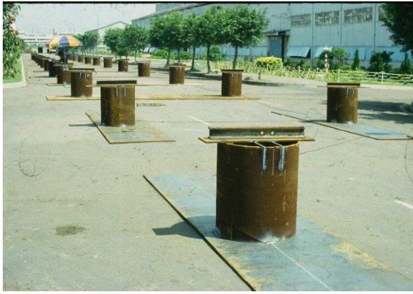
照片 24 穩固的支撐構件(關渡大橋)
