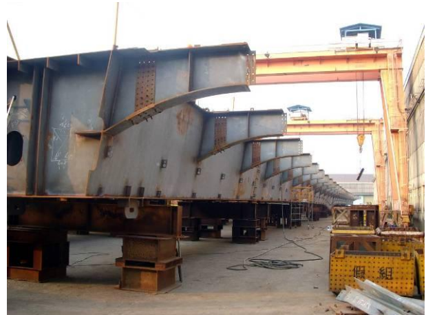
照片 27 構件採多點支撐(春源鋼構)
