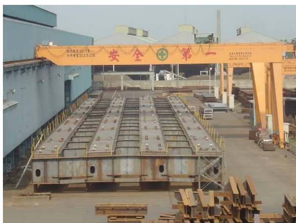
照片-1 鋼橋 (宜鋼鋼構)
