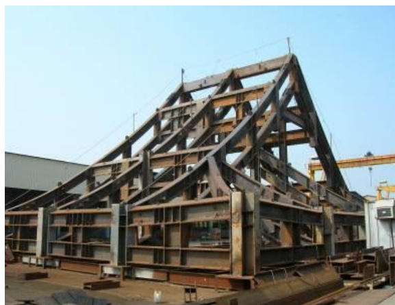
照片-2 大雄寶殿屋頂 (理成鋼構)
