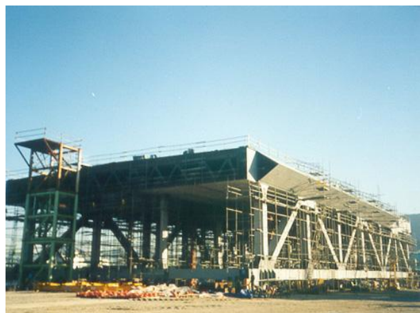
照片 16 分段組合(桁架橋)
