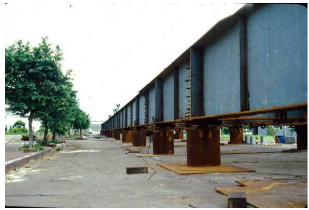
照片 25 穩固的支撐構件(關渡大橋)
