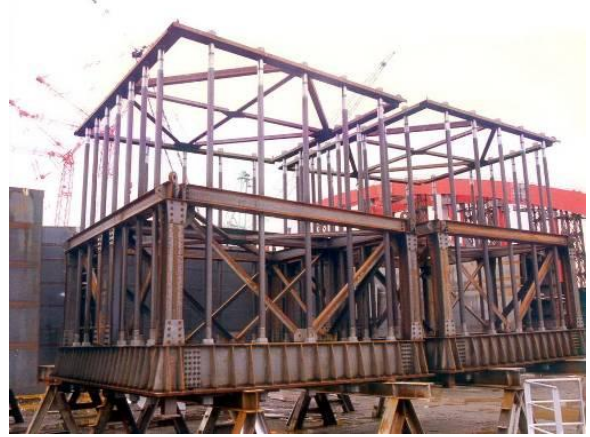
照片 21 鋼橋柱之錨錠構架
