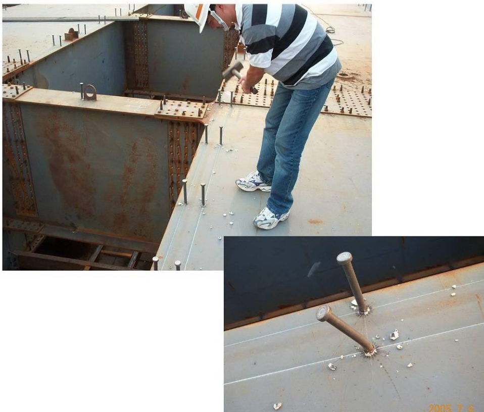
照片 47 剪力釘敲擊檢查
