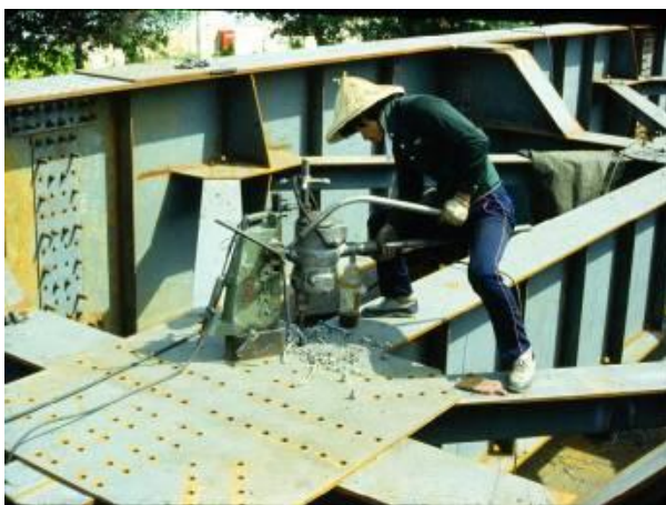
照片-5 斜撐構接頭以擴孔處理
