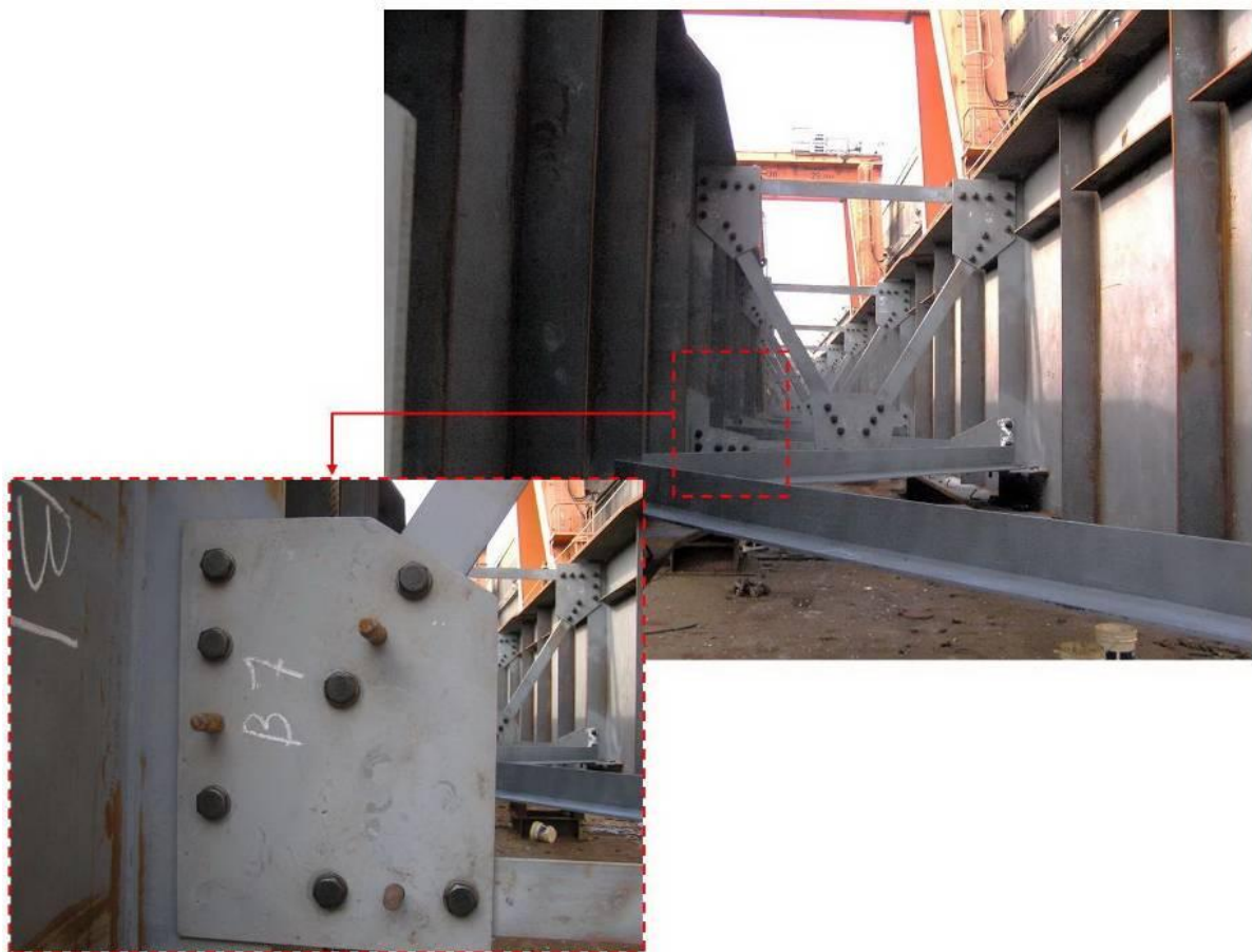
照片 30 臨時螺栓與導孔栓打設 (春源鋼構)
