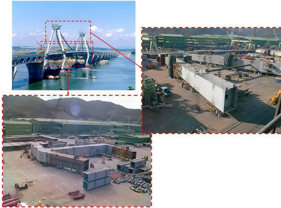
照片 10 橫向預裝(塔柱)
