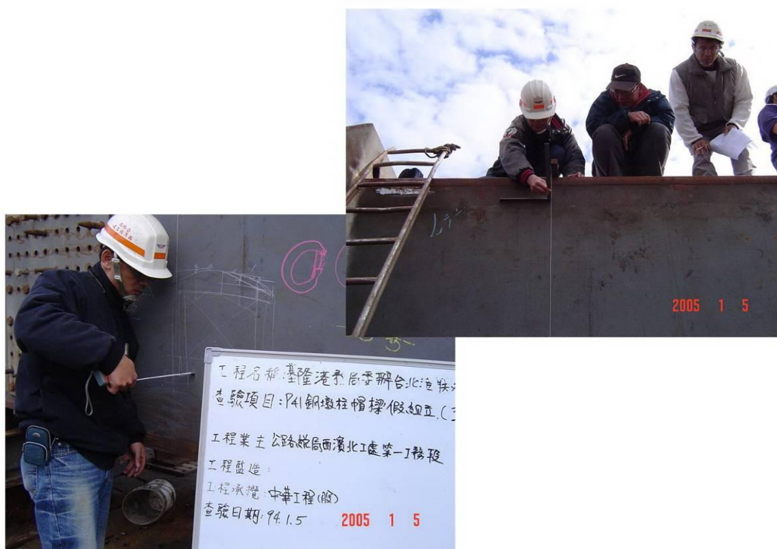
照片 44 主梁腹板正直度檢測(使用鋼琴線)
