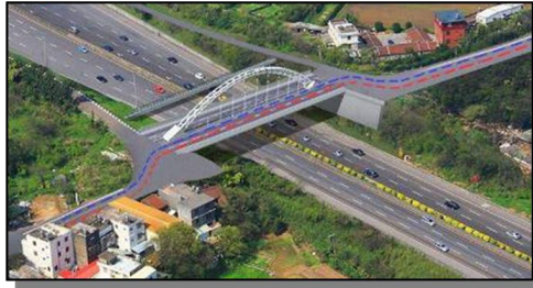
Step 3：拆除舊橋、建新橋台
