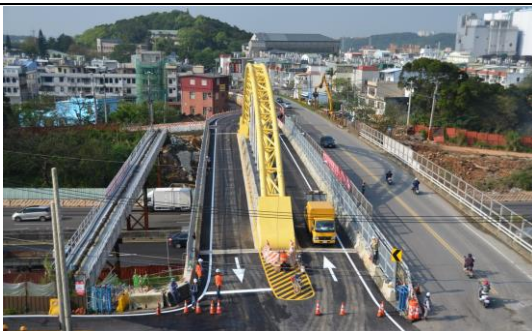
新建跨越橋臨時交通改道
