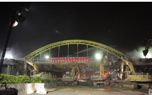
舊跨越橋拆除
