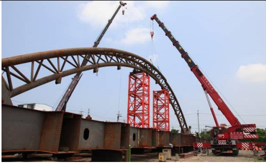
鋼拱橋假組立
