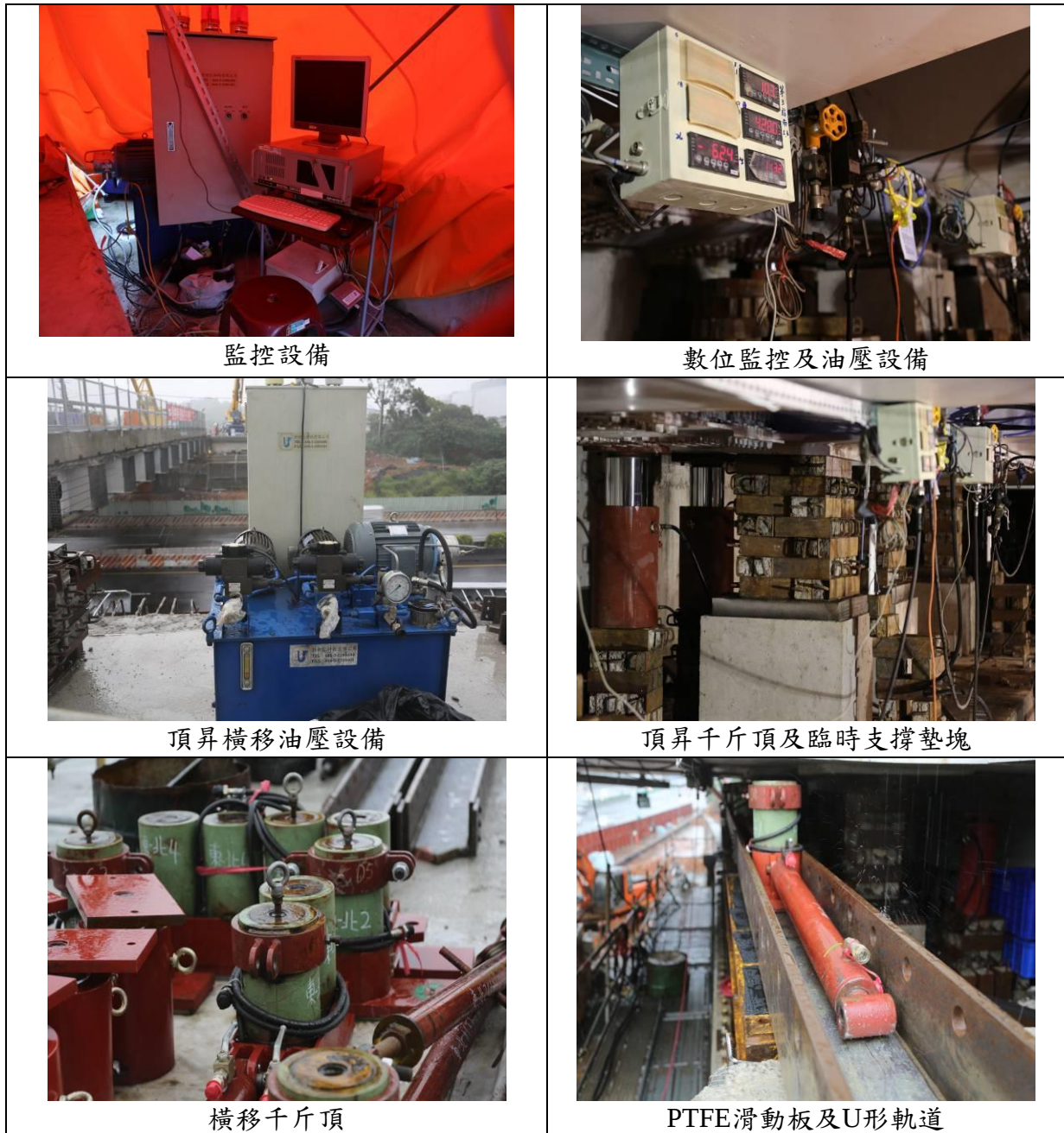
圖11 頂昇橫移施工設備
