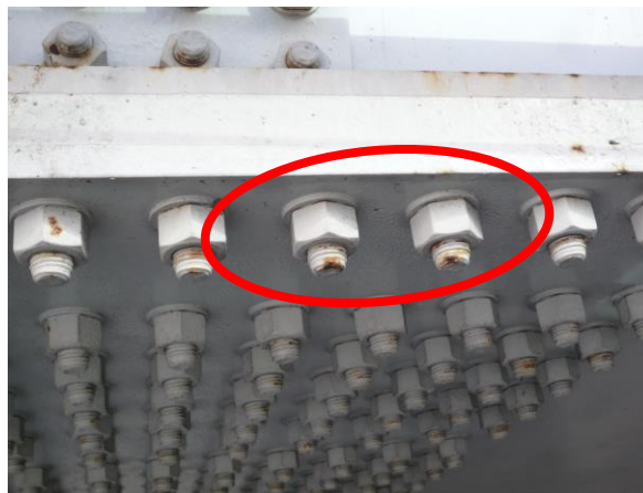
照片 2：銹蝕現象從螺栓斷裂面之毛邊首先產生
