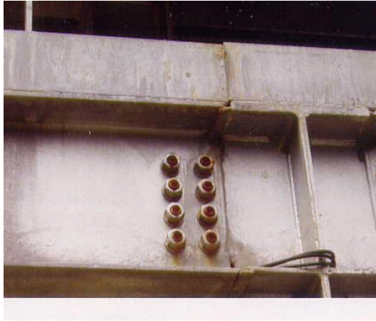
(a) 銹蝕現象從螺栓斷裂面
