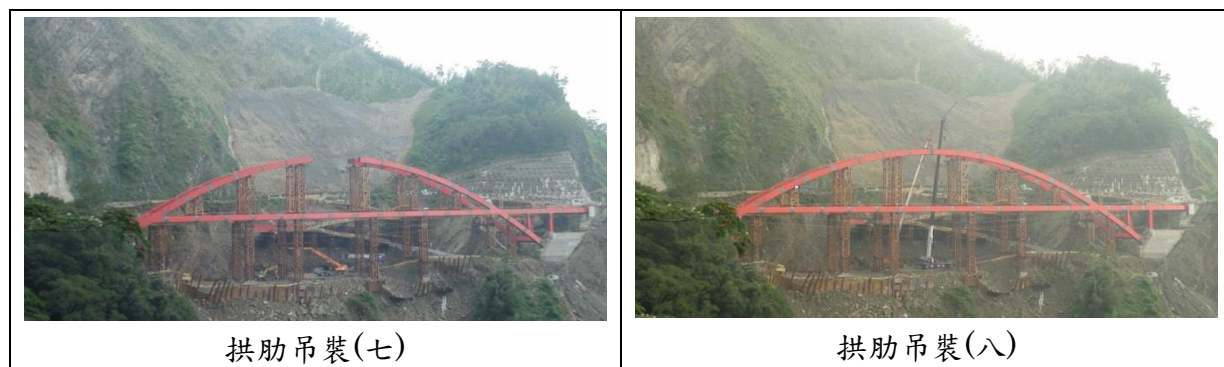
圖 15 拱肋吊裝施工
