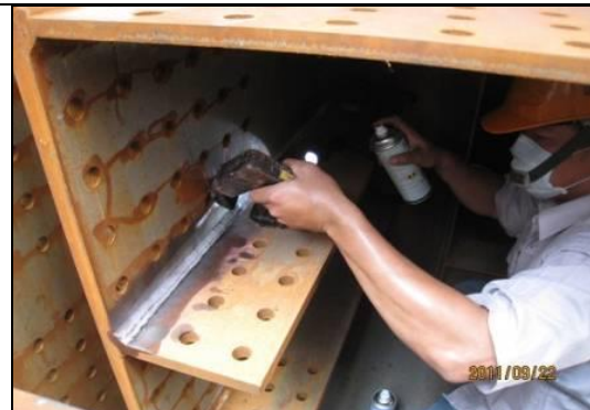
鋼構件焊道 MT 檢查
