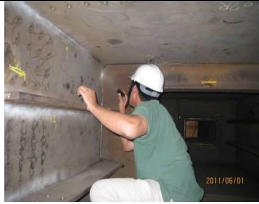
焊道目視檢查
