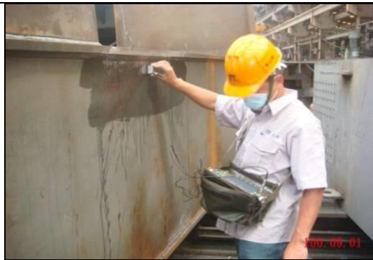
鋼構件焊道 UT 檢查
