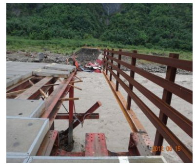
圖 5 洪水沖擊橋梁上構沖毀
