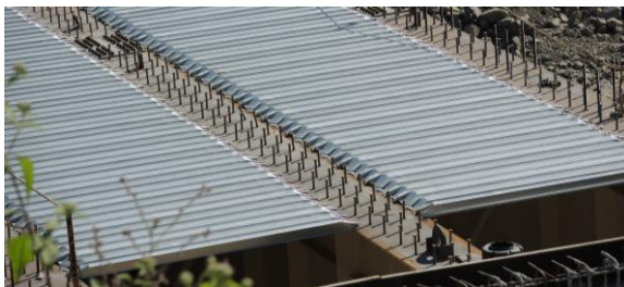
圖 19 I 型梁間浪形鋼板施工情形
