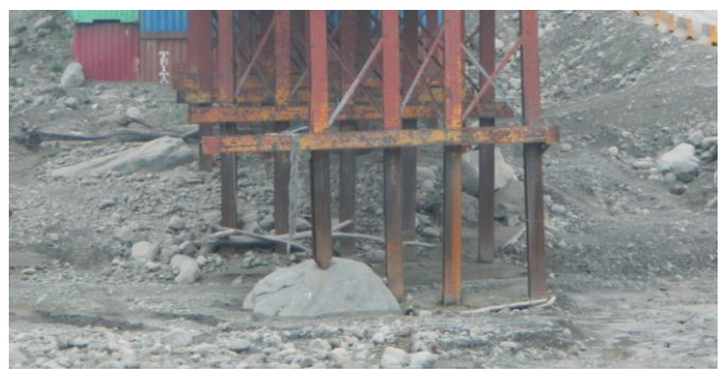
圖 7 H 型鋼下構貫入遇塊石
