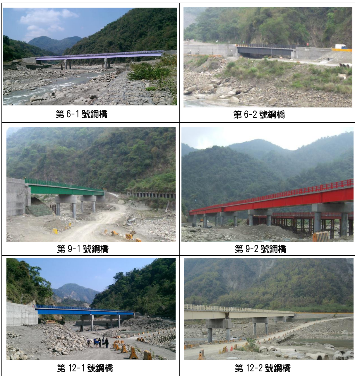
圖 20 12 座中期復建鋼橋完工照片
