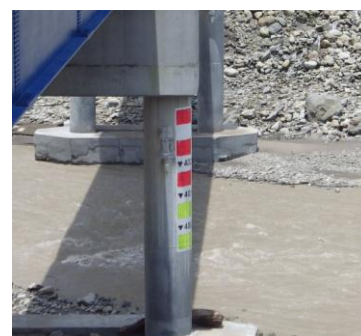
圖 22 封橋水位標示
