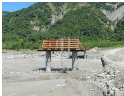
圖 18 橋墩帽梁鋼托架施工情形
