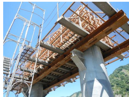
圖 18 橋墩帽梁鋼托架施工情形
