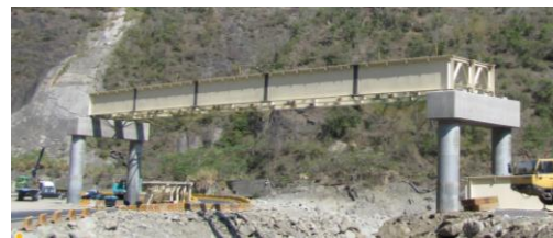
圖 17 鋼 I 梁吊裝施工情形
